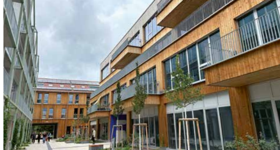
„Stadt in der Stadt“: Höfe, Passagen und unterschiedlich gestaltete Gebäude prägen das Kreativ Quartier Potsdam
